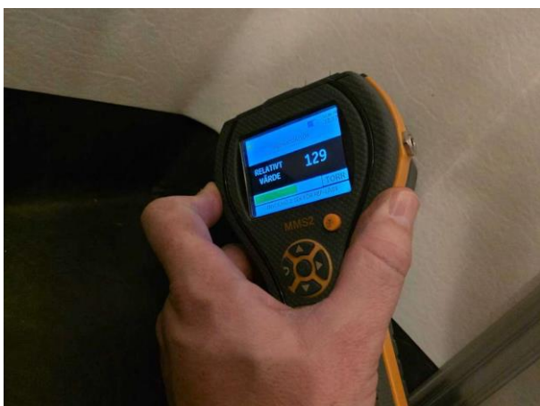
Bild 5: - Invändigt, Entréplan, Rör genomföringar i golv. Inga förhöjda fuktvärden uppmättes vid besiktningstillfället.
