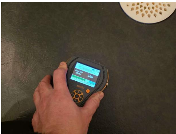
Bild 4: - Invändigt, Entréplan, Rör genomföringar i golv. Inga förhöjda fuktvärden uppmättes vid besiktningstillfället.
