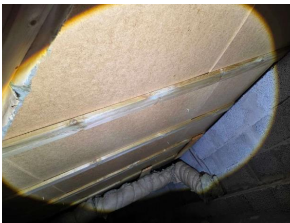
Bild 2: - Utvändigt, Grundmur/Hussockel, Krypgrund, se riskanalys Inga förhöjda fuktvärden uppmättes i grund.
